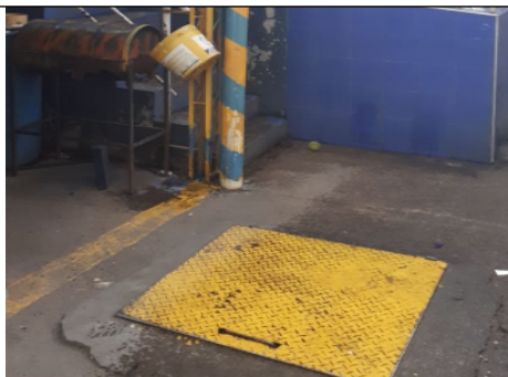
Foto No. 5. Tanque de Almacenamiento de Agua Lluvia
