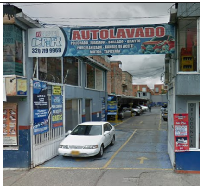
Foto No. 1. Vista General del Predio
