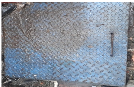
Foto No. 3. Visita Superior del Pozo
